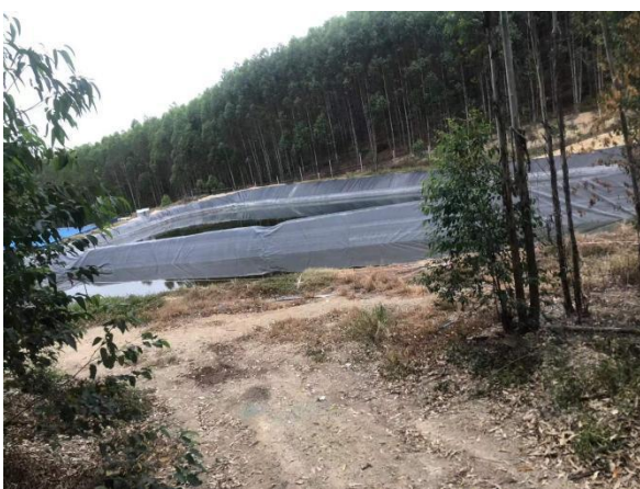
养殖废水无害化处理（储粪池生物氧化池）
