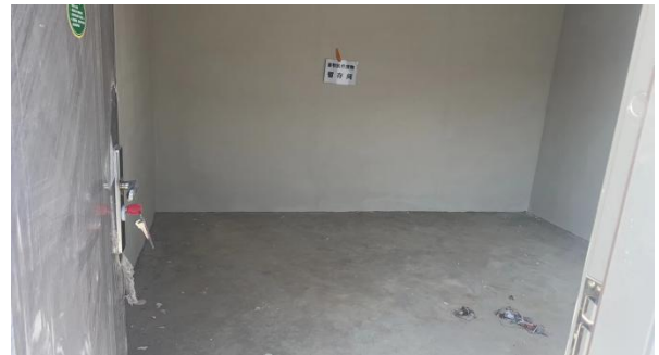
医疗废物暂存间
