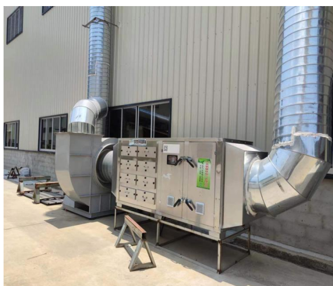
集气罩+UV 光解催化废气处理设备+活性炭吸附装置
