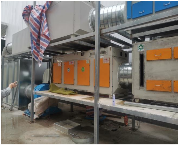
密闭厂房+水帘装置+UV 光解净化器+活性炭环保处理箱
