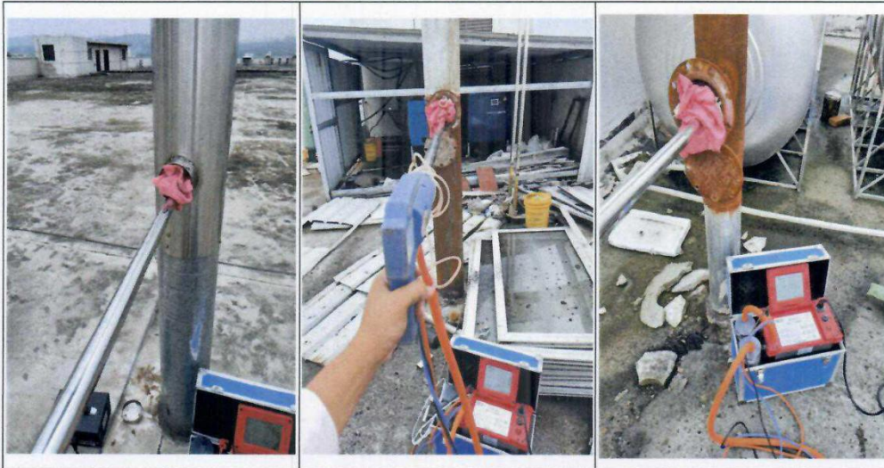
有组织废气 1#油烟排气筒
