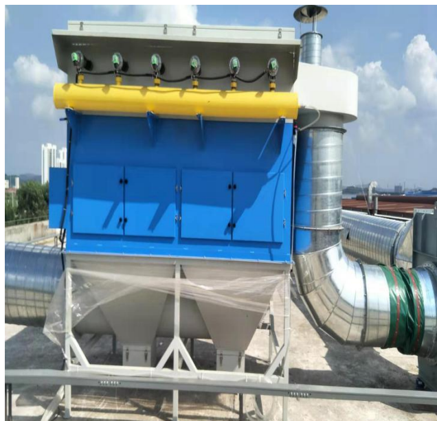
脉冲式滤筒除尘器
